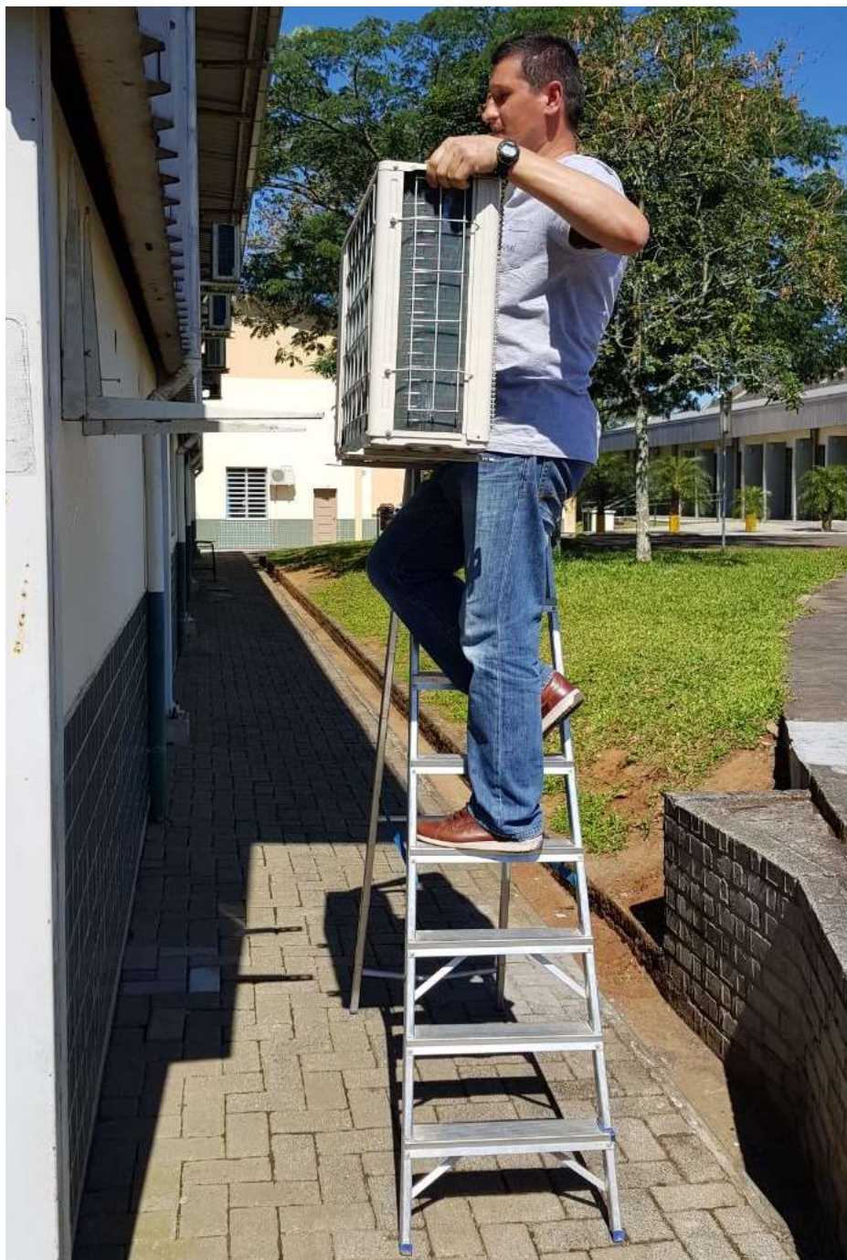
Figura 4: Foto de aluno instalando a unidade externa.
