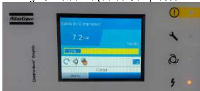
Fig.25: Estabilização do Compressor.
