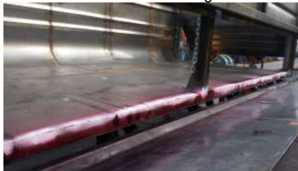
Figura 15: Pode-se observar a região da dobra. (a).
