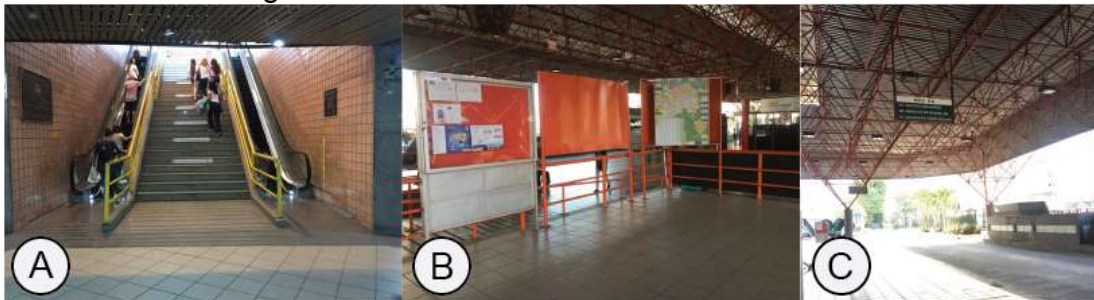
Figura 8: Terminal central de Criciúma – SC.
