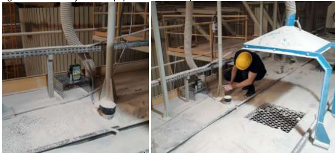
Figura 18: Instalação do equipamento na empresa CEUSA.
