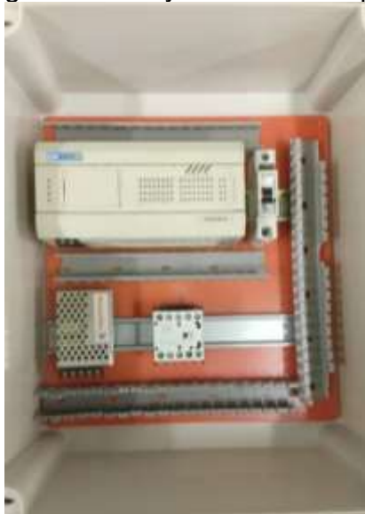
Figura 15 – Layout interno do painel.
