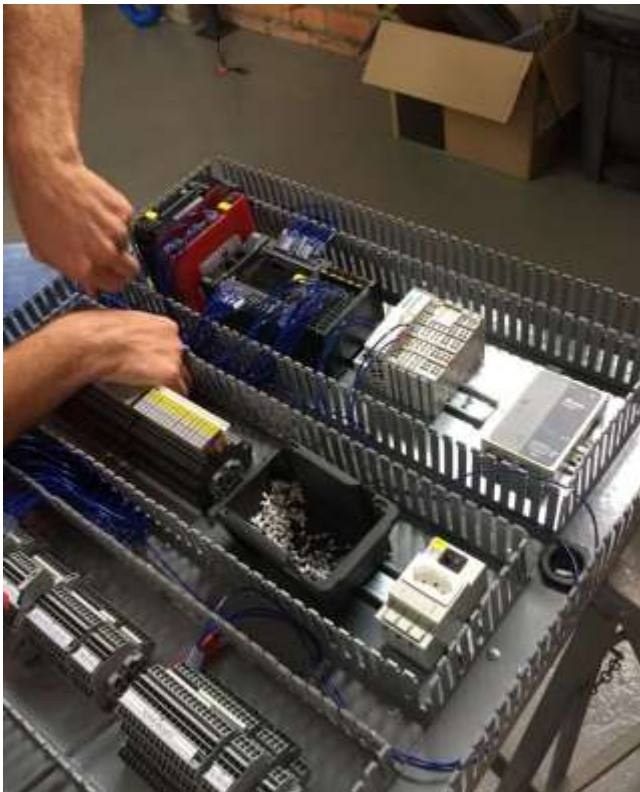
Figura 7: Montagem do painel elétrico.
