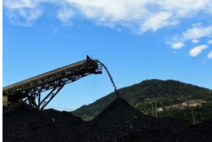
Figura 2: Correia Transportadora Mina Fontanella.
