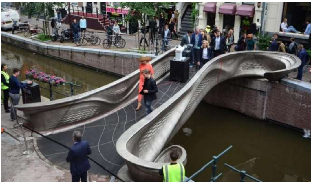
Figura 1: Primeira ponte produzida por Manufatura Aditiva em aço inoxidável. Fonte: Brogan (2021).
